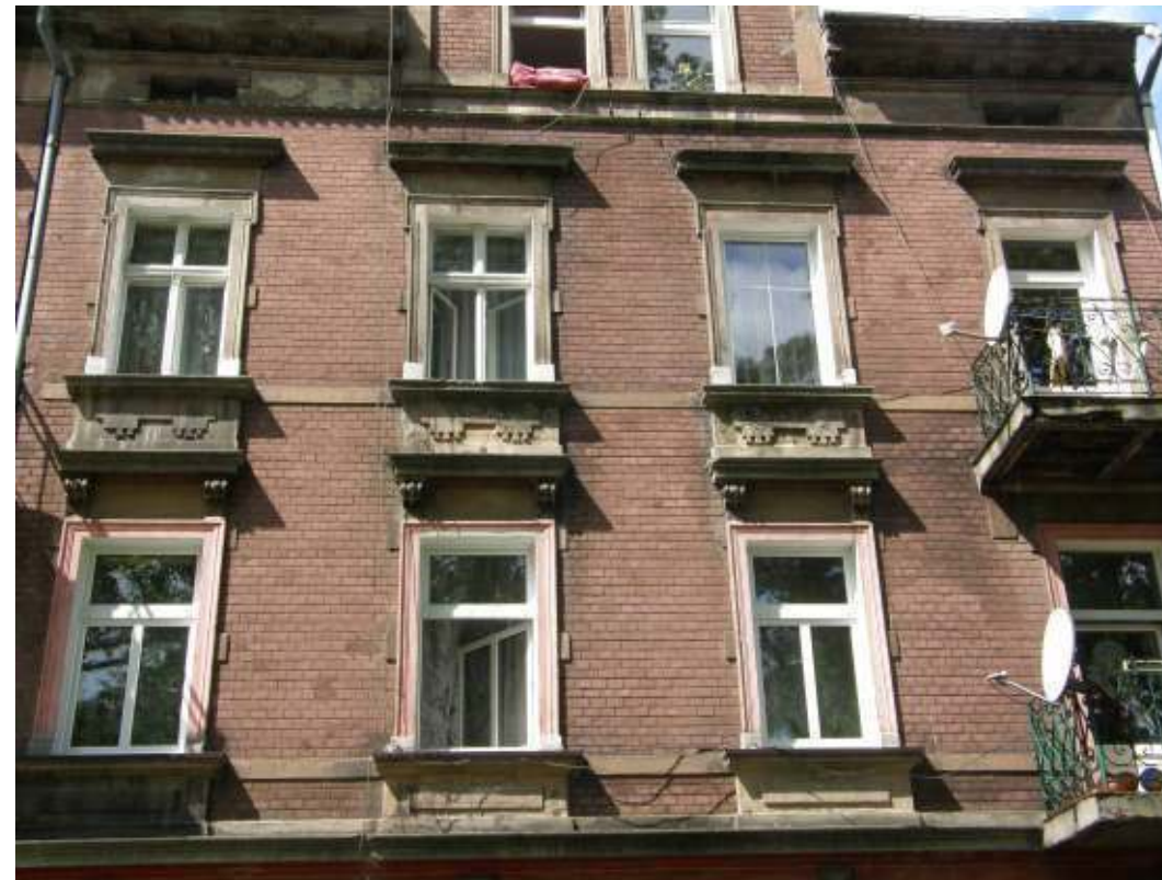
Fot. Elewacja frontowa
