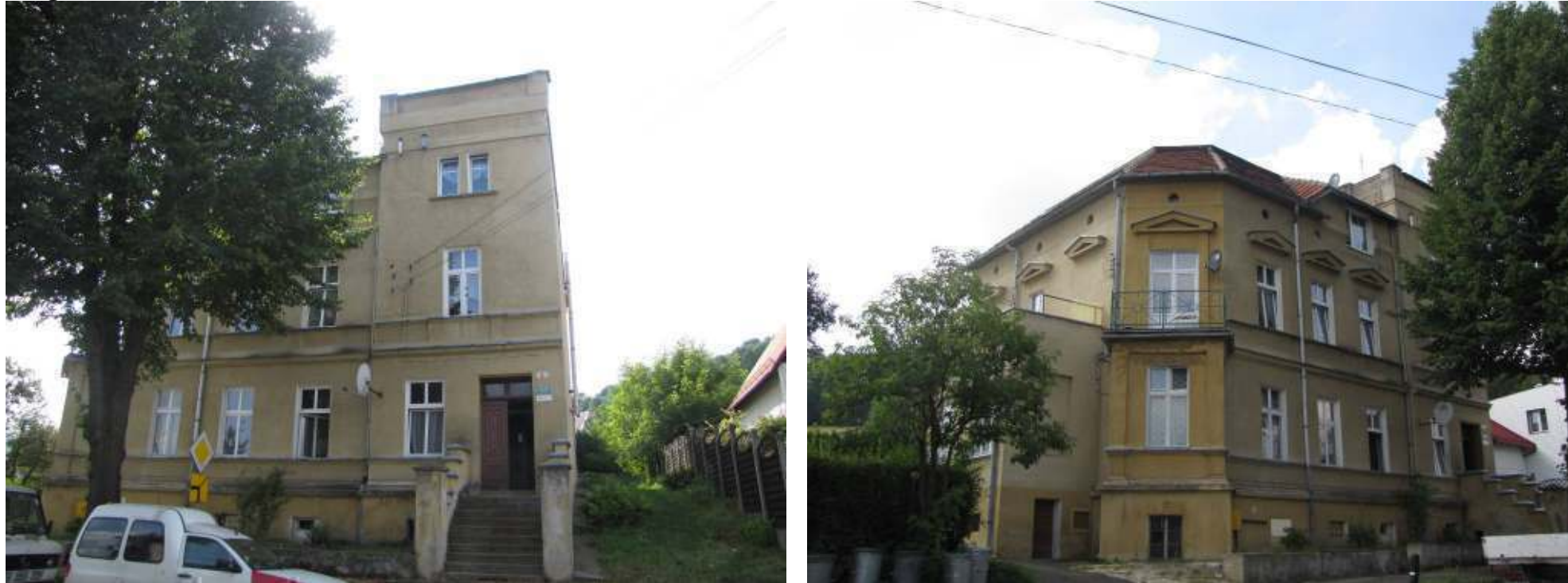
Fot. Elewacja frontowa i boczna
