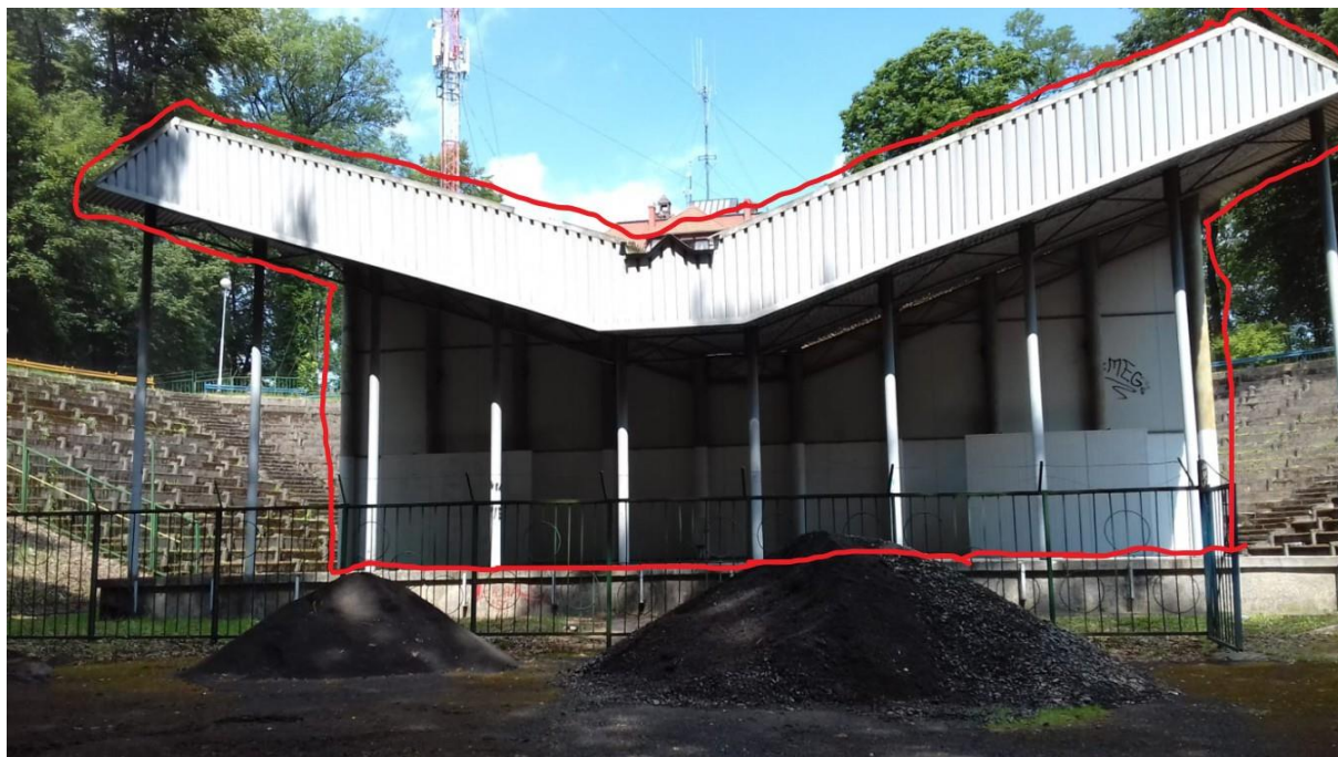
Zaplecze sceny vis-à-vis wejścia technicznego na teren Amfiteatru.
